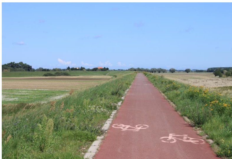
Fot. 62. Ścieżka rowerowa (R9 i R10) na koronie wału przeciwpowodziowego Wisły w północno-wschodniej części Tczewa
