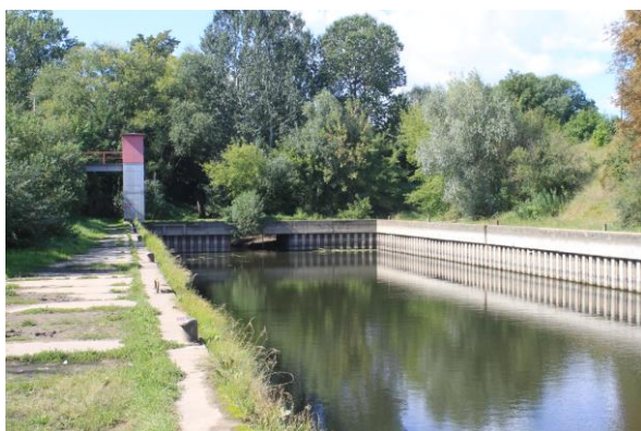
Fot. 12. Kanał Młyński w odcinku przyujściowym w betonowej obudowie
