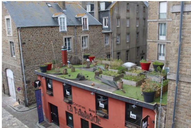
Fot. 67. Zielony dach w wersji ubogiej
