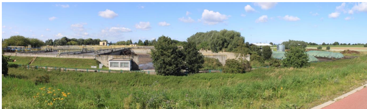
Fot. 59. Oczyszczalnia ścieków w Tczewie – widok z wału przeciwpowodziowego Wisły
